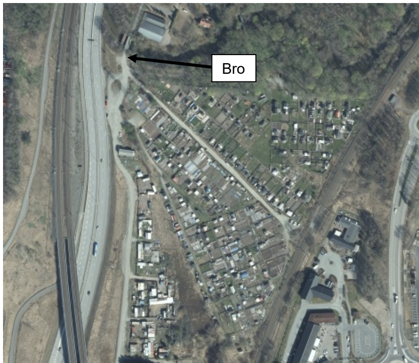
Figur 6-6 Läge på bron där vattenståndet i Lärjeån mätts ifrån.
